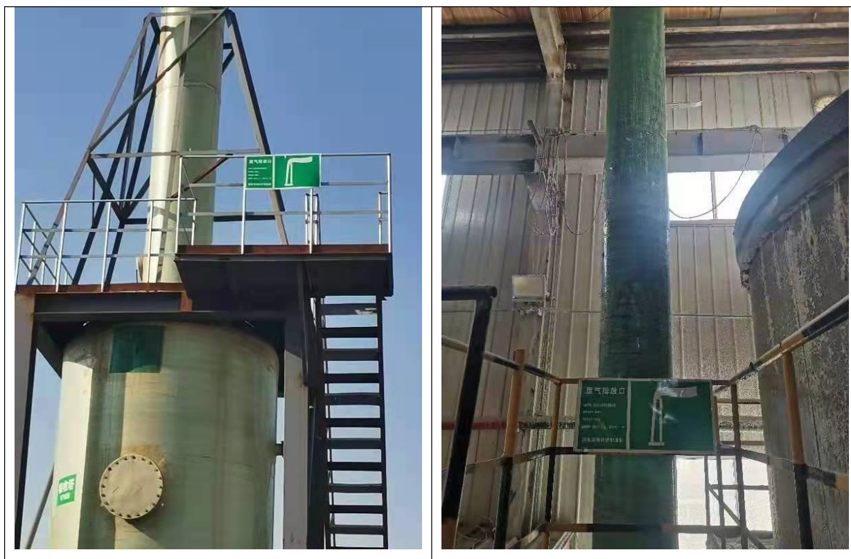
图 4-7 采样口、采样平台及标识
